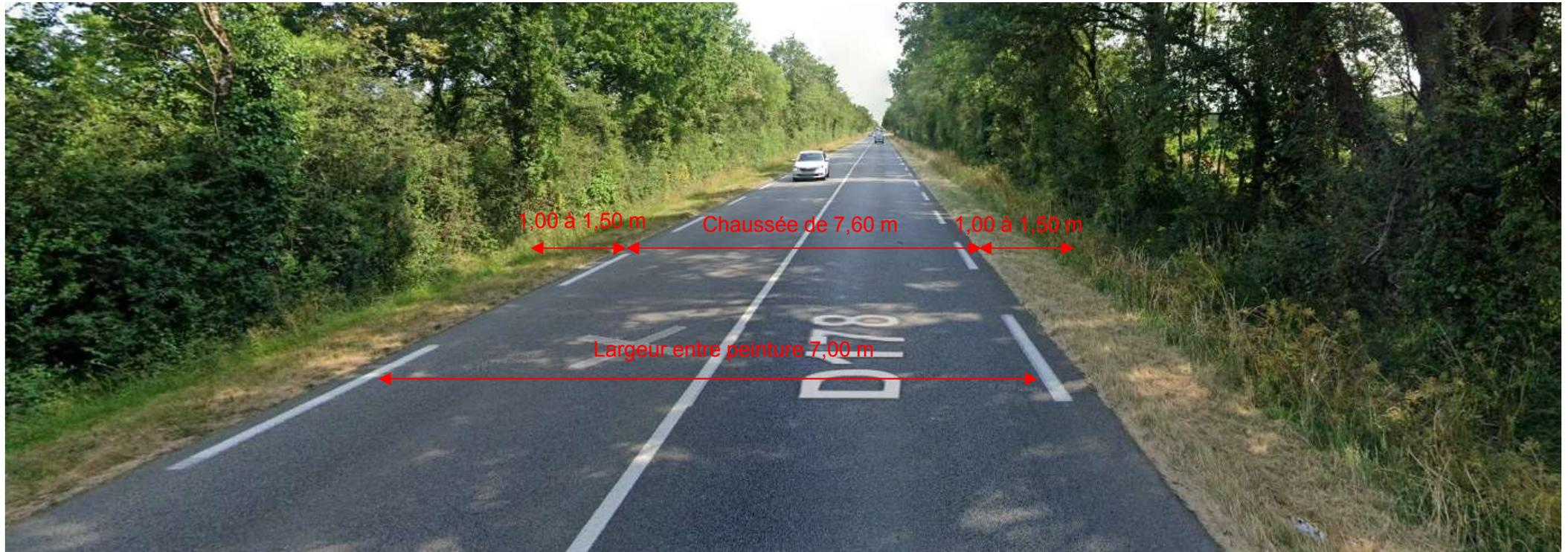
↪ Couche de roulement renouvelée au cours de l'été 2024 comprenant la mise en place d'une bande continue avec dispositif sonore en axe de chaussée
